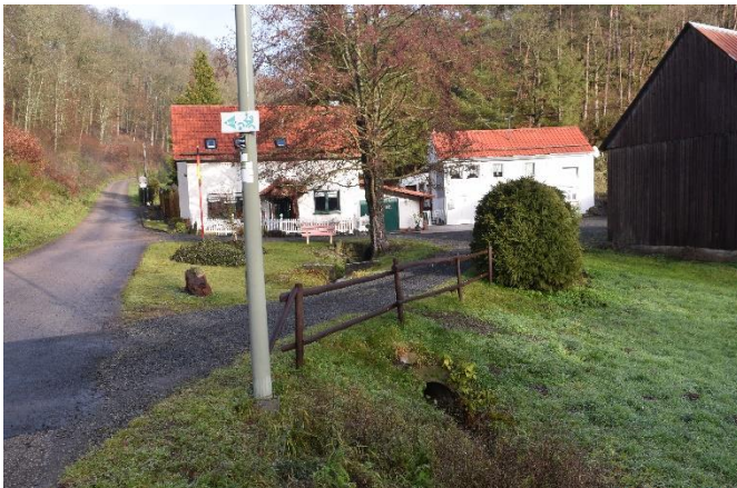
Gefährdete Bebauung am Littersbach
