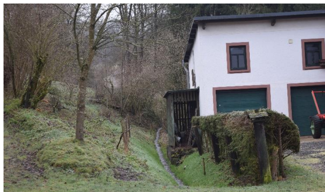
Brühlenbach vor der Straße „Zum Borngarten“
