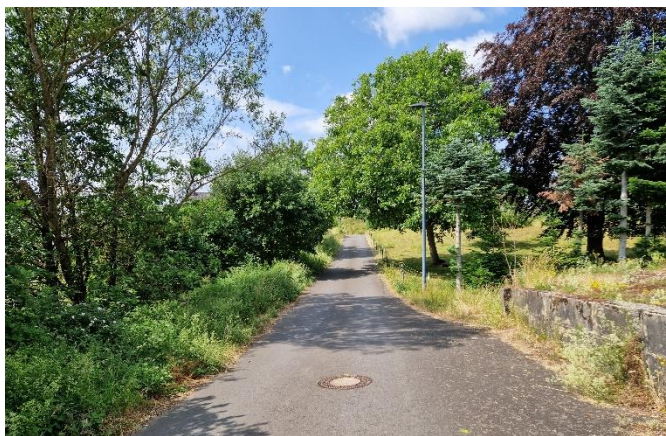
Straße „Tuchwiese“: Bachdurchlass in der Bildmitte
