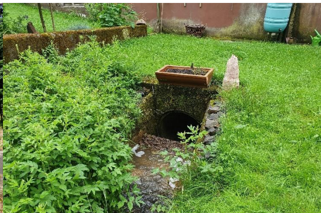
Einlassbereich in die Verrohrung hinter Hauptstraße 45
