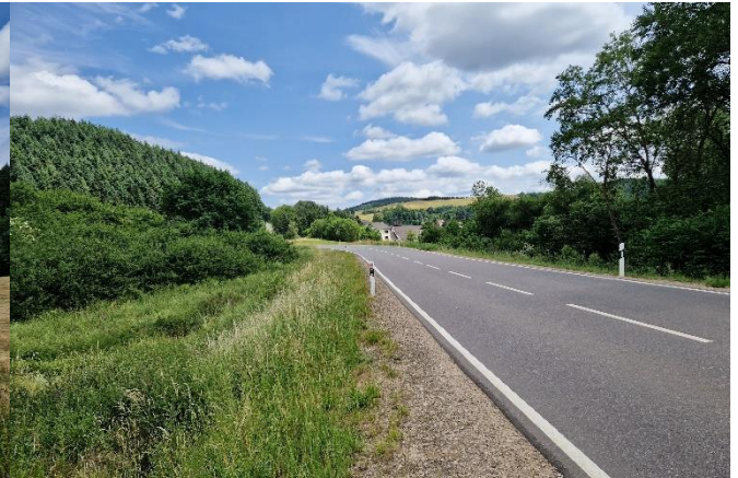
B 257 am Durchlass, Fließrichtung von links nach rechts
