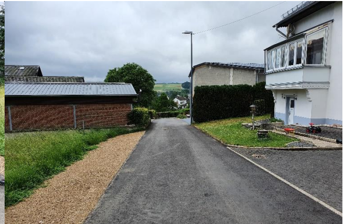
Blick entlang des nun asphaltierten Abschnitts
