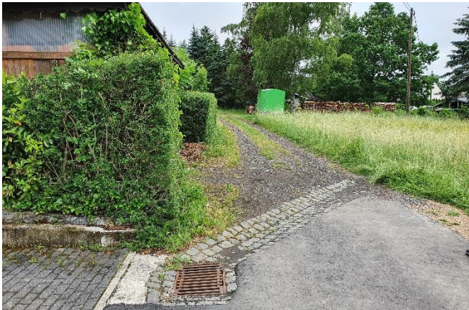
Geschotterter Weg und Einlassschacht
