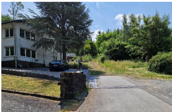
Entwässerungseinrichtungen am Objekt Höhenstraße 9
