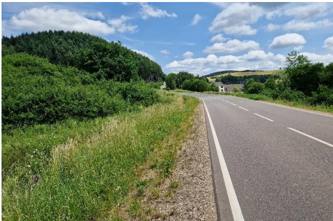
B 257 im Bereich des Kirbach-Durchlasses
