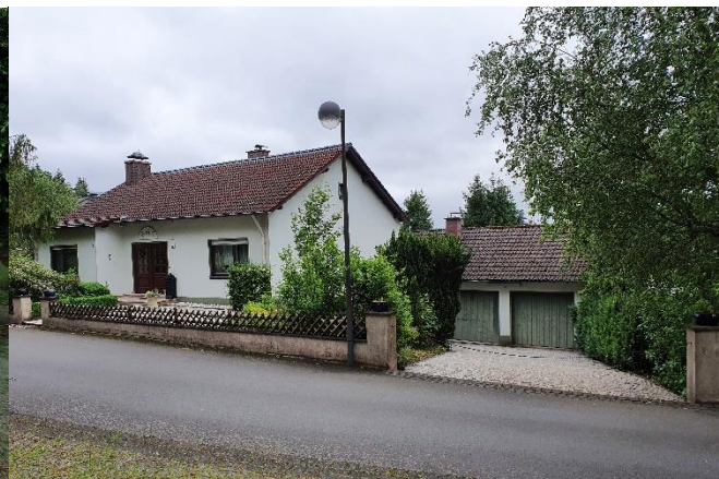
Gefährdete Garage am Objekt Höhenstraße 2
