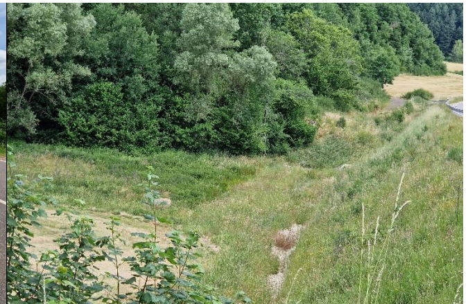
Durchlass im Straßendamm
