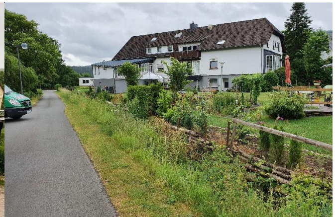
Blick in Fließrtg. zur Schulstraße: Nutzung bis zum Bach
