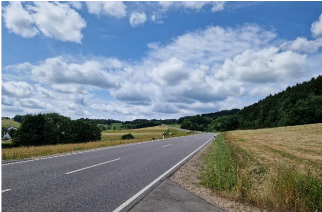
B 257 am Wirtschaftsweg im Bereich des Durchlasses
