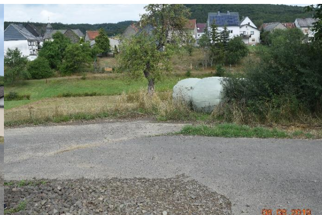
Herstellung Notabflussweg in den Birkenhofbach
