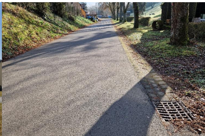
Entwässerung in der Siebenbachstraße, Bereich Nr. 8-10
