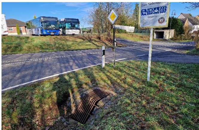
Einlassbauwerk am Ortseingang an der B 421
