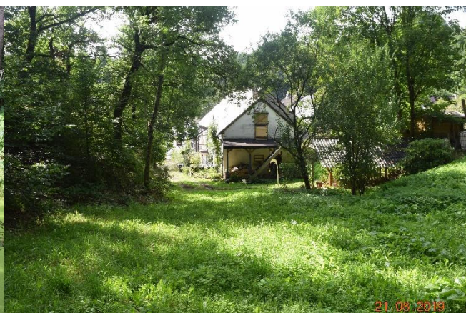
Gefährdetes Objekt unterhalb der Teichanlagen
