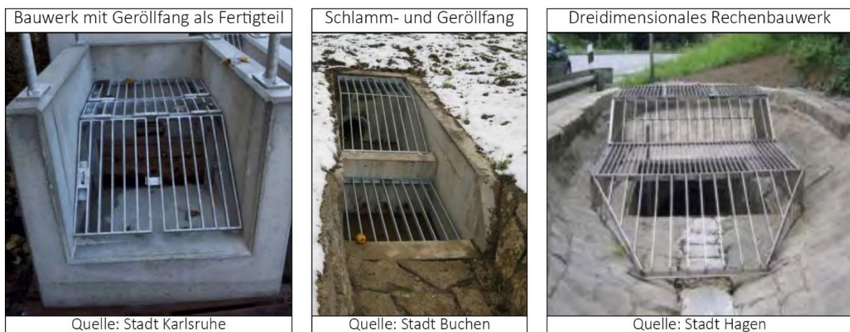
Abb. 10: Beispielhafte Verbesserung von Einlaufbauwerken an Gräben und vor Verrohrungen
