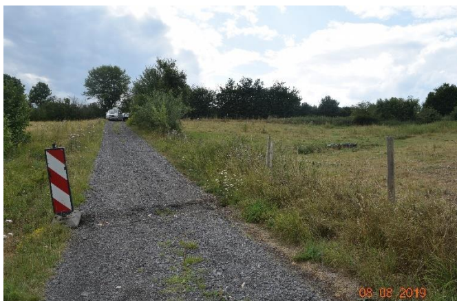
Wasserführender Weg zur Kläranlage
