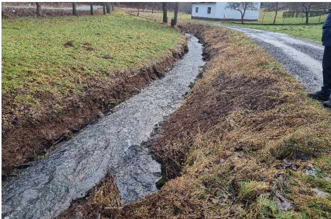
Auslass der Wintersbachverrohrung unterhalb der L 91
