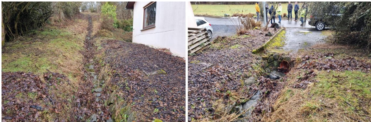
Abb. 7: Entwässerungsrinne von der L 91 in den Wintersbach, Bereich „Im Graben 14“
