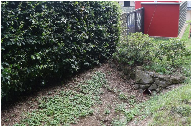
Einlass in die Verrohrung der Außengebietsentwässerung
