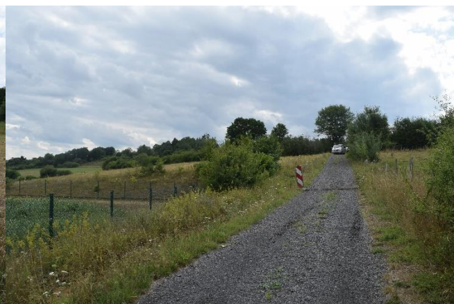
Weg entlang der Kläranlage, Becken im Foto links
