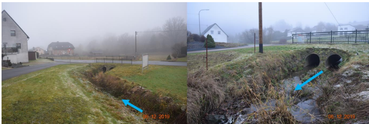
Abb. 14: Doppelverrohrung Hauptstraße
