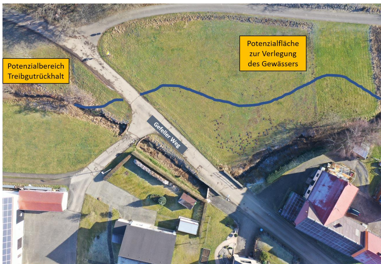
Abb. 12: Verlegung des Sarmersbaches im Gefeller Weg
