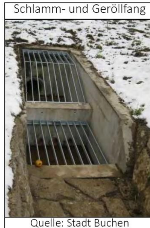
Abb. 7: Beispielhafte Verbesserung von Einlaufbauwerken an Gräben und vor Verrohrungen
