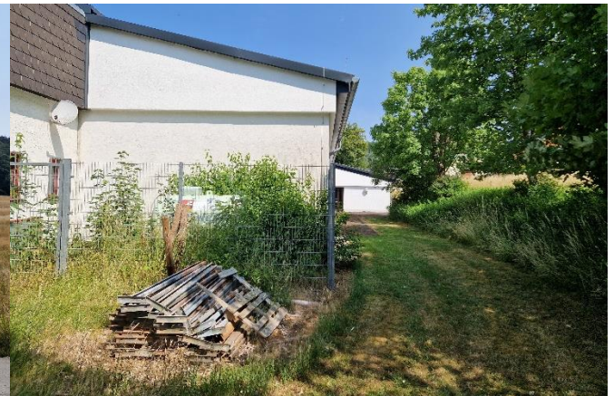
Rückseite der Gebäude mit Gastank
