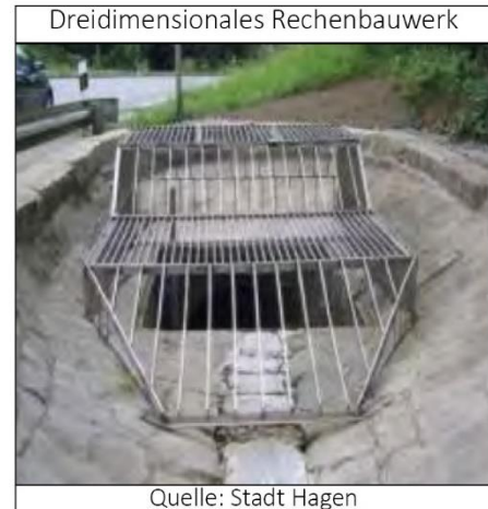
Abb. 7: Beispielhafte Verbesserung von Einlaufbauwerken an Gräben und vor Verrohrungen
