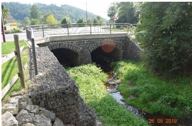
Kleine Kyll vor dem Brückenbauwerk der B 257
