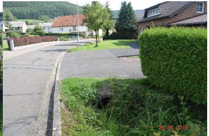
Verrohrung unter einer Grundstückszufahrt
