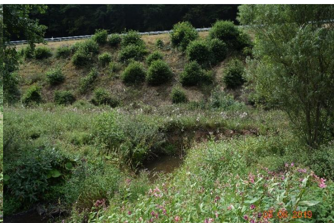
Erosion an der Böschung unterhalb der L 27
