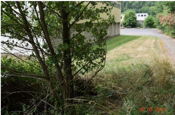
Einlass in die Verrohrung des Risselbaches am Schulgelände
