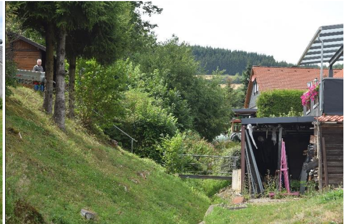
Bauliche Anlagen am Bach in Höhe Tulpengasse
