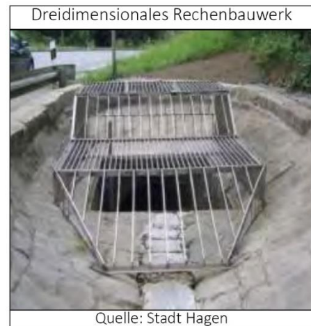
Abb. 9: Beispielhafte Verbesserung von Einlaufbauwerken an Gräben und vor Verrohrungen
