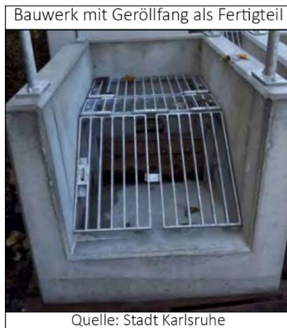
Abb. 9: Beispielhafte Verbesserung von Einlaufbauwerken an Gräben und vor Verrohrungen
