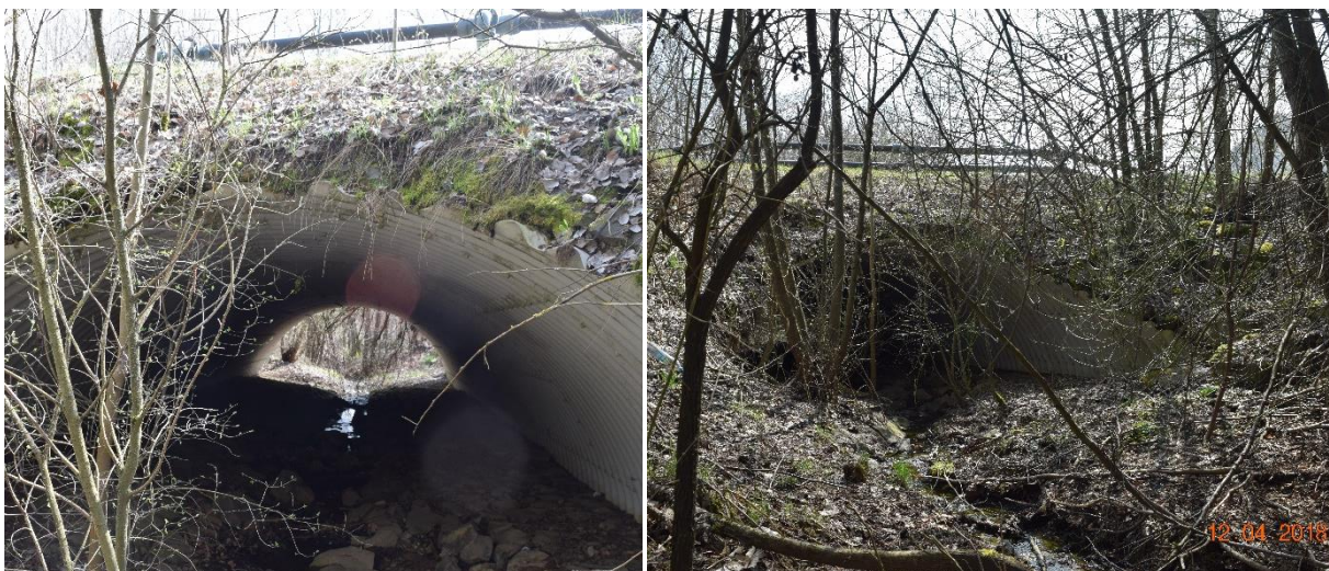
Abb. 18: Nadelwaldgraben am Durchlass Konrad-Zuse-Straße (in Fließrichtung)
