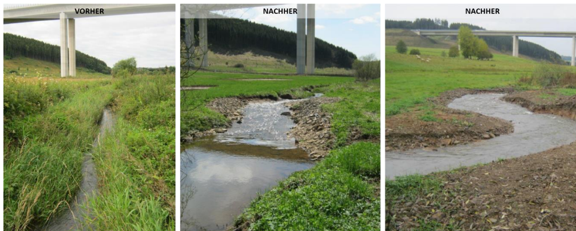
Abb. 16: Renaturierung der Lieser zwischen Nerdlen und Daun-Rengen (Quelle: SGD Nord)
