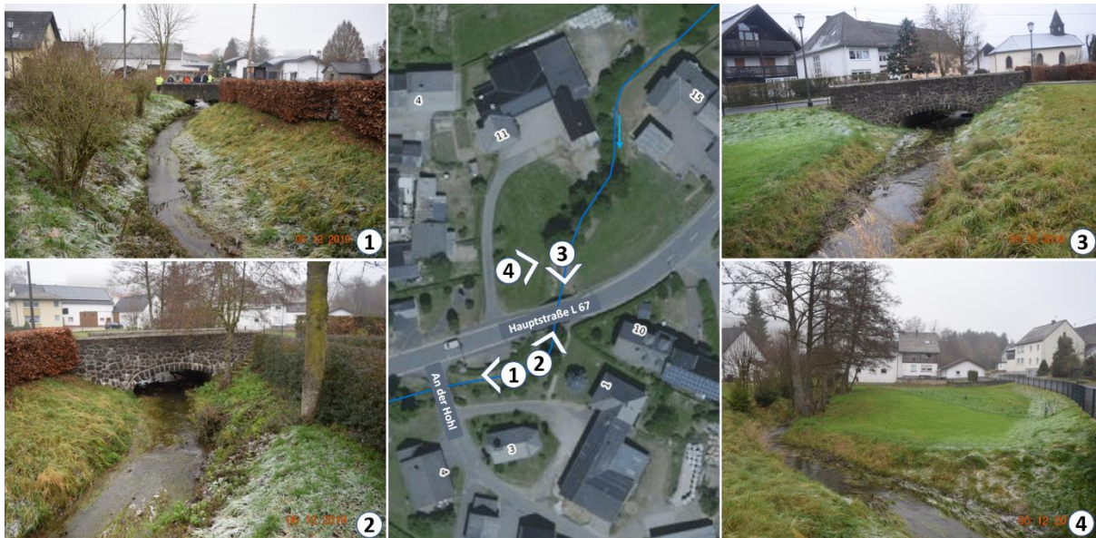
Abb. 14: Sarmersbach in der Ortslage im Bereich der Brücken Hauptstraße und An der Hohl
