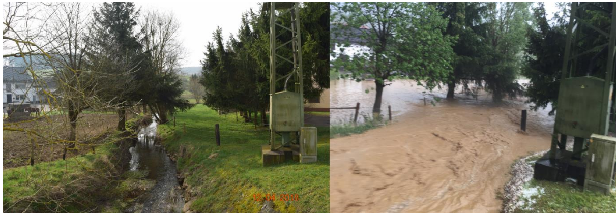
Abb. 12: Strommast an der Lieser unterhalb der Brücke Hauptstraße (Blick in Fließrichtung)
