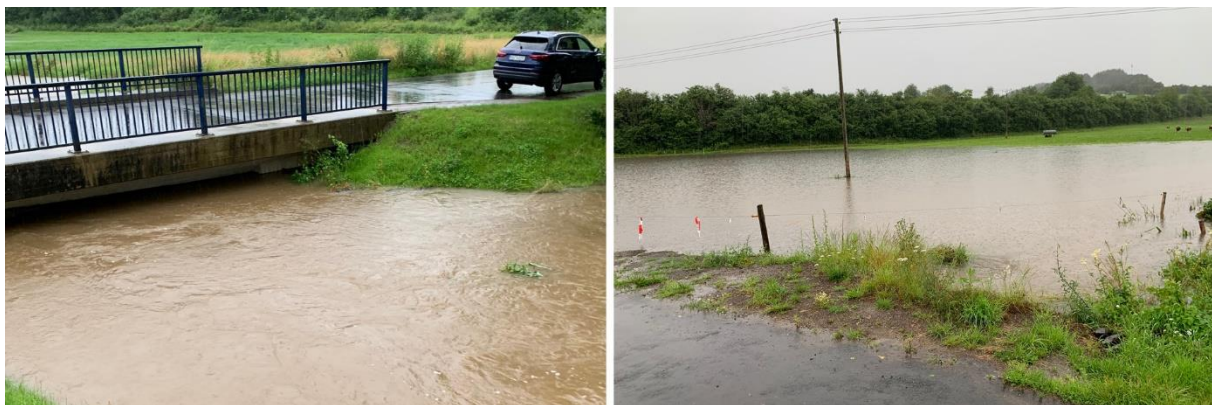
Abb. 6: Hochwasser an der Brücke bei „apra-norm“ und am Schalkenmehrener Bach (rechts) (Fotos: Erwin Umbach)
