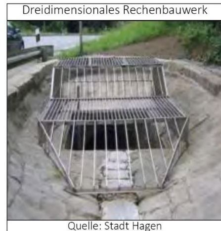
Abb. 8: Beispielhafte Verbesserung von Einlaufbauwerken an Gräben und vor Verrohrungen
