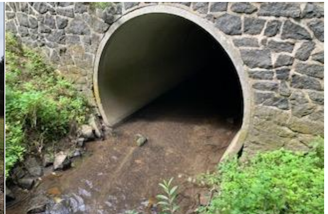
Neuer Durchlass am Bach (Foto: E. Umbach)
