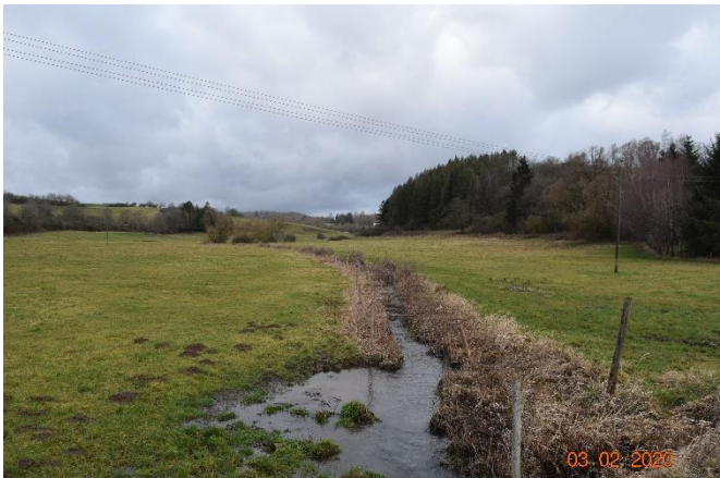
Retentionsraum am Bach vor dem Wegedurchlass
