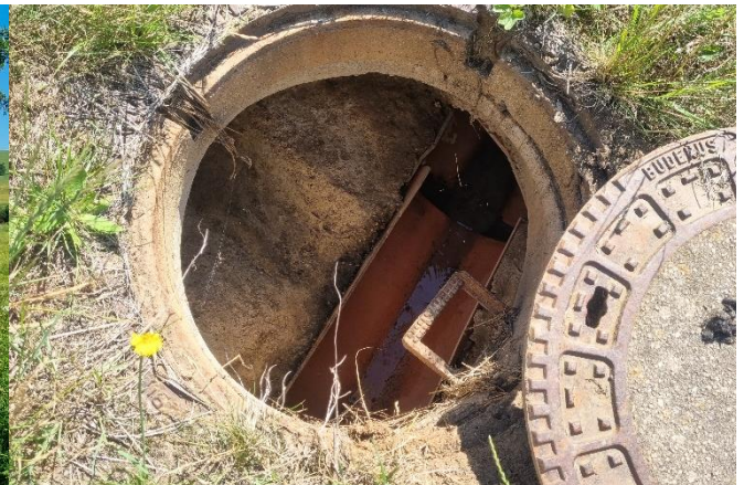
Verrohrung mit zwei Einleitungen
