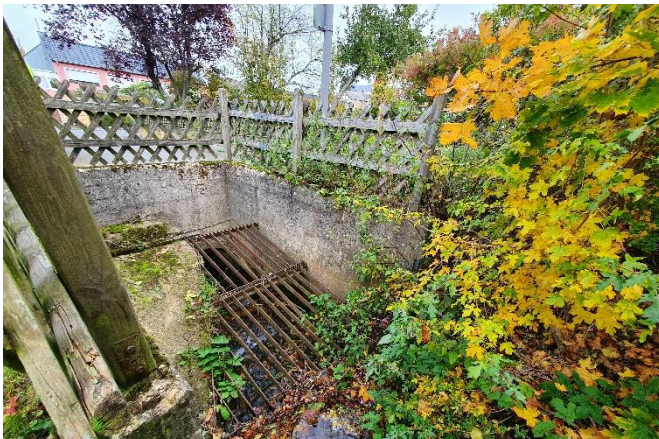
Kirchweilerbach: Einlassbauwerk an Hauptstraße
