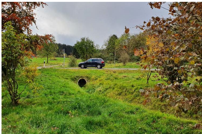
Auslass des Dorfgrabens unter der L 27
