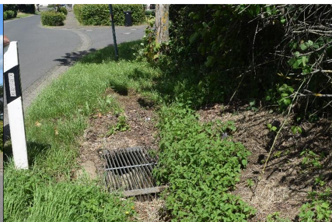
K 36: Einlassbauwerk am Straßengraben
