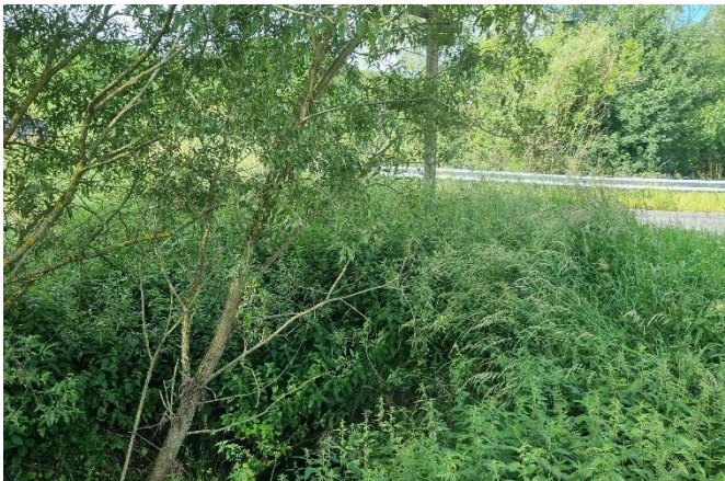
Durchlass am Wirtschaftsweg im Außengebiet (nahe L 27)
