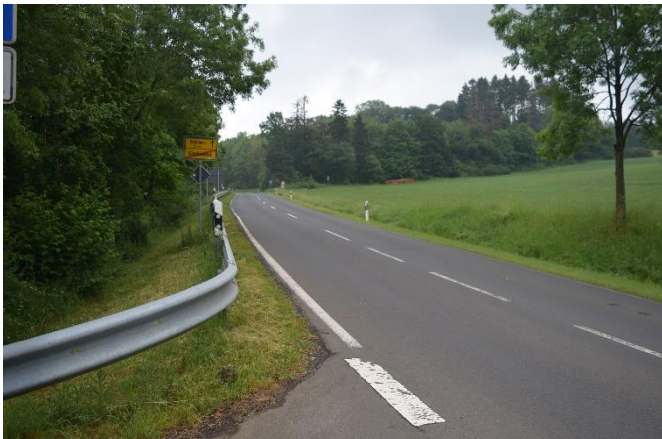
Grabenentwässerung L 28, entgegen der Fließrichtung
