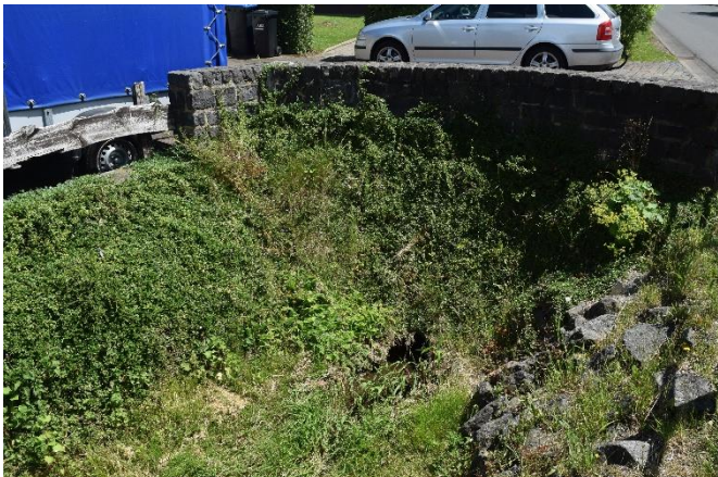
Auslass Obergraben, Mündung in Hinterweilerbach
