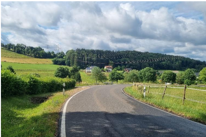
Kreisstraße (linksseitig: Einlassbauwerk)
