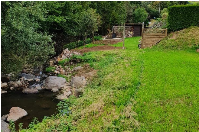
Verbauter Gewässerabschnitt (Höhe Mühlenweg 6)
