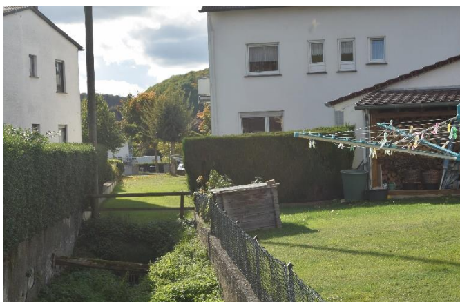
Einlassbauwerk in die Verrohrung an der Strohrner Straße
