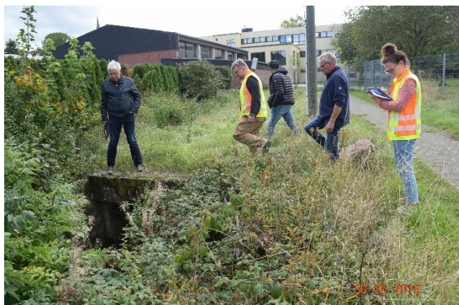
Einlass in die Verrohrung am Schulgelände
