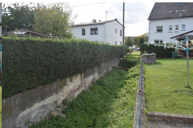
Gewässerabschnitt vor der Verrohrung
