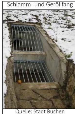
Abb. 9: Beispielhafte Verbesserung von Einlaufbauwerken an Gräben und vor Verrohrungen
