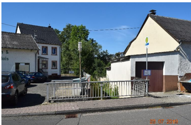
Bachbrücke, Blick in Fließrichtung
