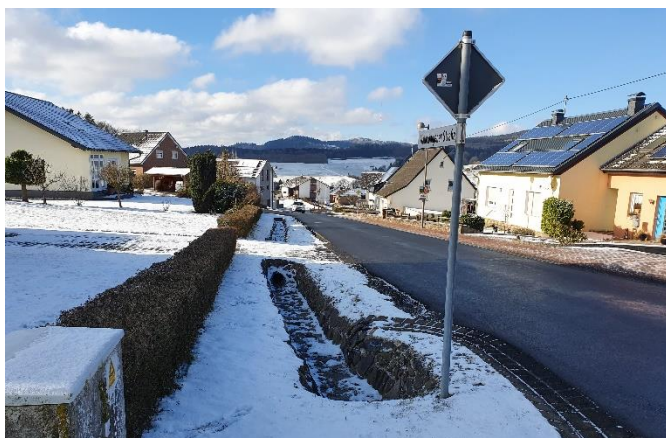
Entwässerungsgraben und Durchlässe an der Straße
