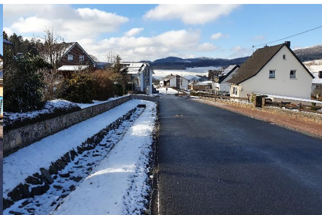
Entwässerungsgraben und Durchlässe: Ecke Waldschulweg
