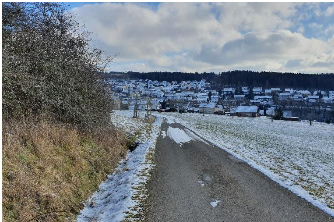
Entwässerungsgraben am Wirtschaftsweg
