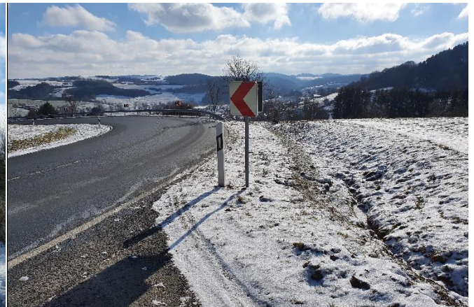
Entwässerungsgraben an der L 28, oberhalb Quellenweg
