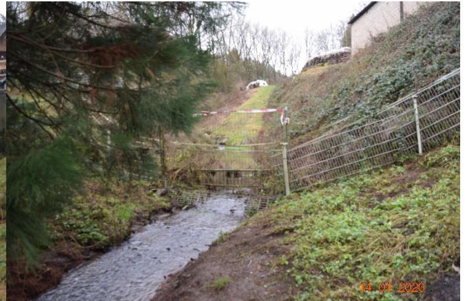
Rechen im Zulauf zum Einlassbauwerk
