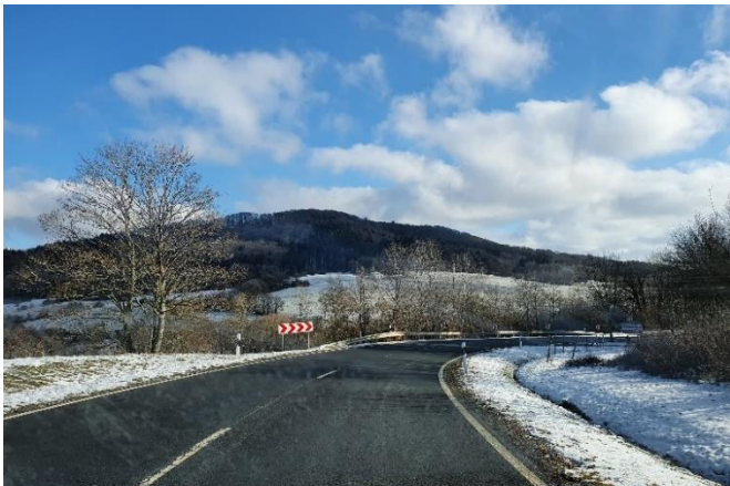
Kurvenbereich der L 28, Seitengraben rechts
