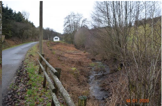
Hippersbach (gg. die Fließrtg.) vor dem Straßendurchlass
