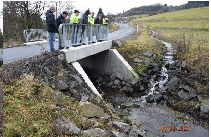
Durchlass Pützborner Bach in der K 11
