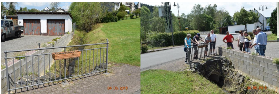
Abb. 17: Baubach in der Rengener Straße – gegen die Fließrichtung (links) und in Fließrichtung (rechts)
