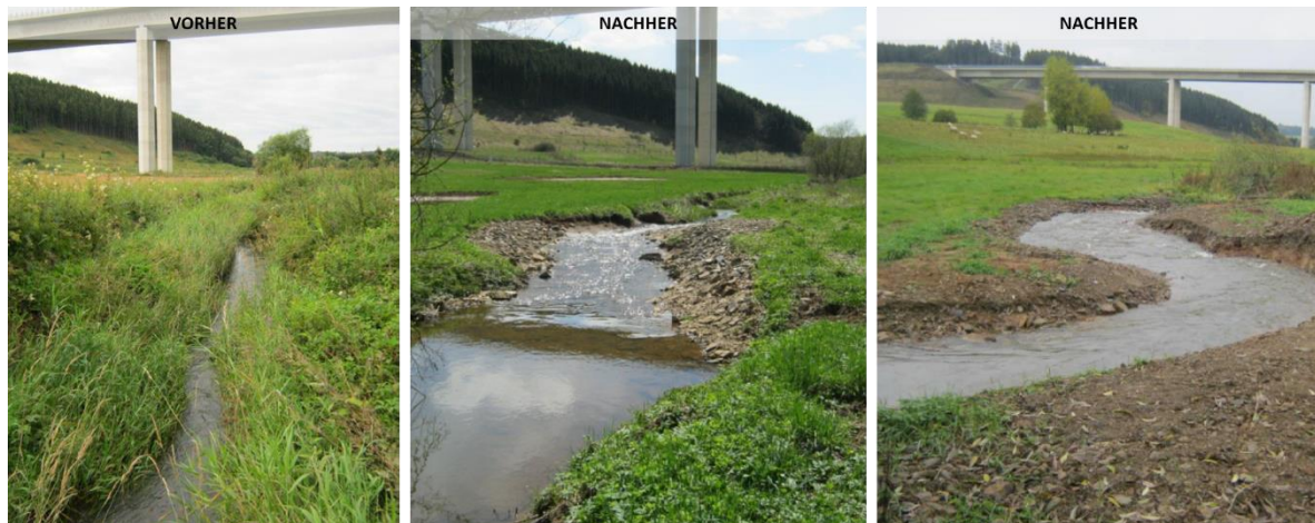
Abb. 12: Renaturierung der Lieser zwischen Nerdlen und Daun-Rengen (Quelle: SGD Nord)
