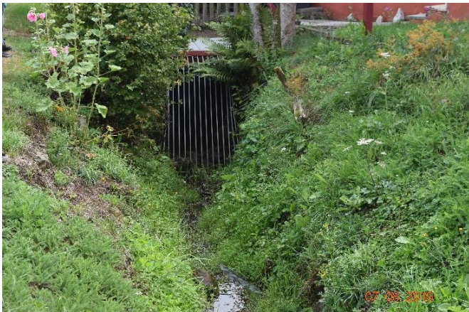
Einlassbauwerk in die Verrohrung des Pützbaches
