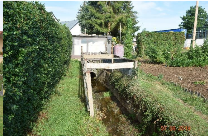
Auslass des Pützbaches vor Mündung in den Pützborner Bach
