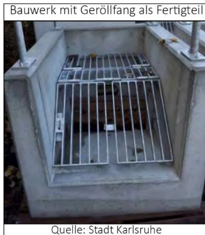
Abb. 8: Beispielhafte Verbesserung von Einlaufbauwerken an Gräben und vor Verrohrungen
