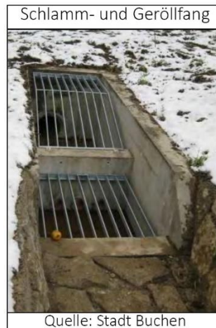
Abb. 8: Beispielhafte Verbesserung von Einlaufbauwerken an Gräben und vor Verrohrungen
