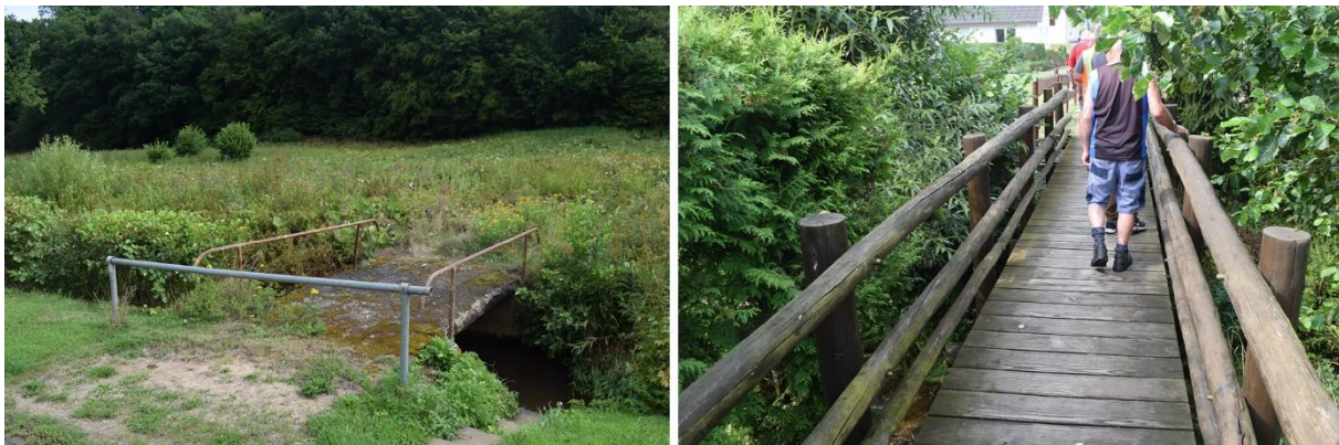
Abb. 5: Mittlerweile entfernte Betonbrücke und Fußgängerbrücke „Im Hasenfeld/ Alte Rossgasse“
