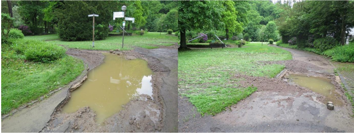
Abb. 33: Hochwasserschäden im Kurpark 2016
