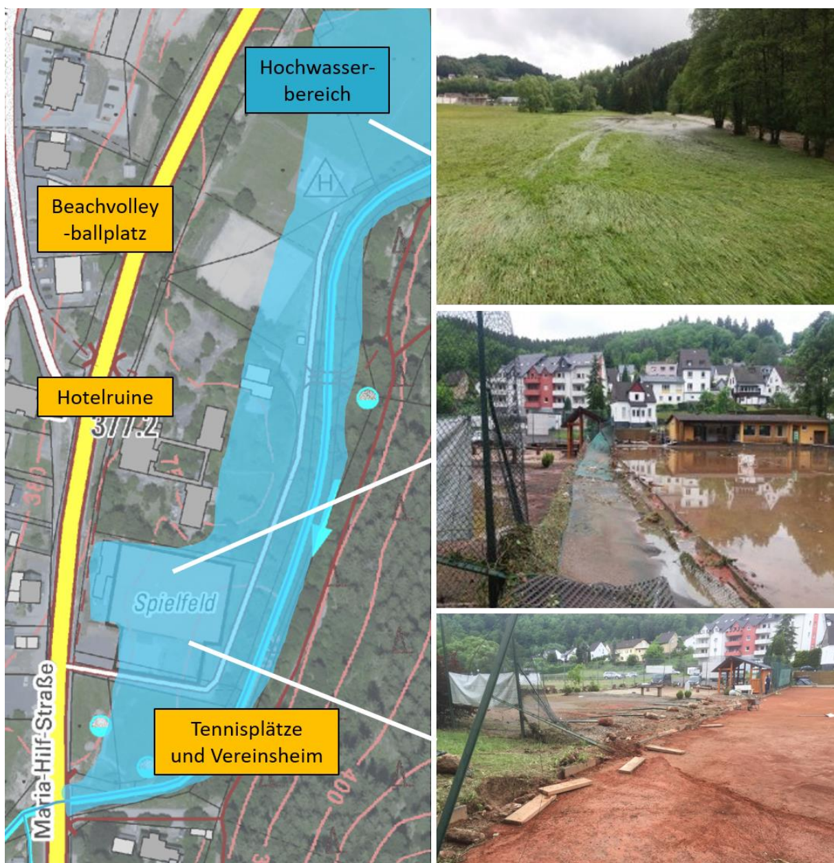
Abb. 30: Überschwemmungsbereich am Sportgelände des TuS Daun
