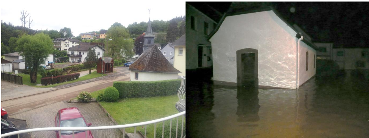
Abb. 3: Überfluteter Bereich an der Kapelle Gemünden nach dem Hochwasser und währenddessen
